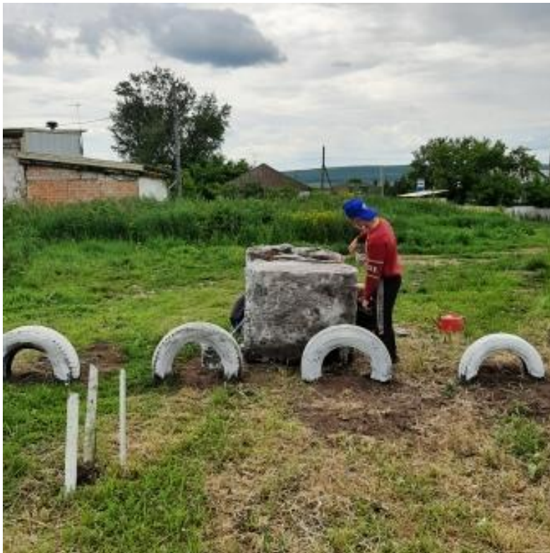
Покраска и установка стеллы.
